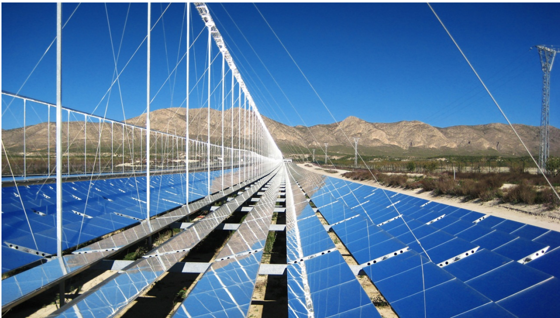
Abbildung 19: Das Fresnel-Solarfeld Puerto Errado in Calasparra, bei Murcia im Süden Spaniens [37].
