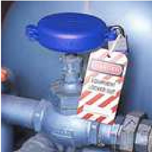
Abbildung 14: Mittels LoTo abgesichertes Ventil [21]
