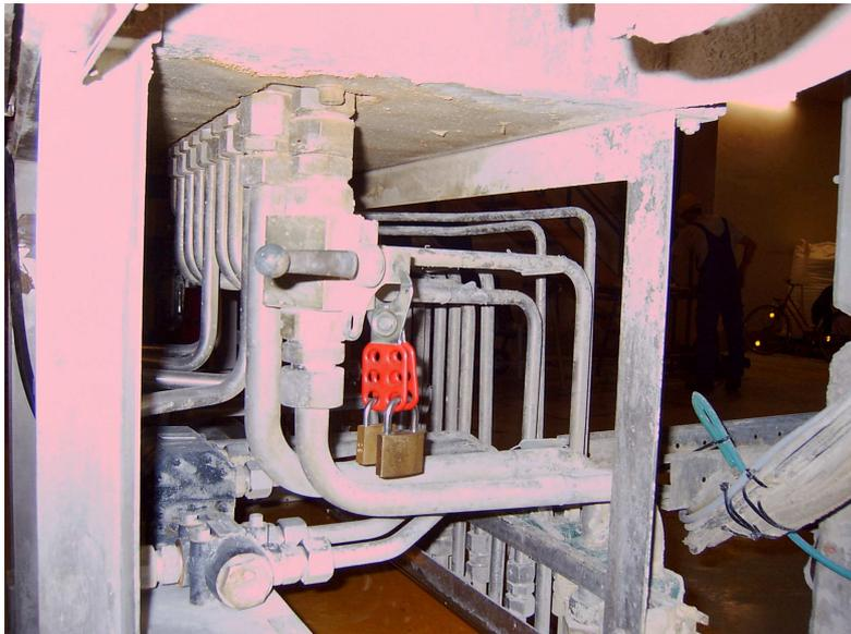
Abbildung 24: Ausgesichertes Ventil
