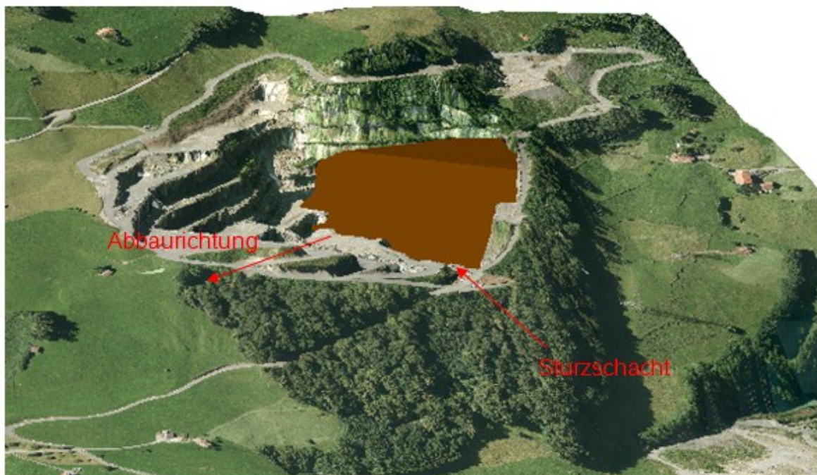
Abbildung 21: Zwischenlager Steinbruch Hettis
