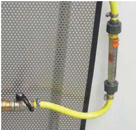
Abb. 15: Einstellung und Messung des Durchflusses
