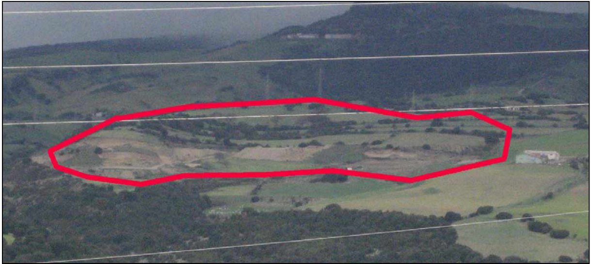
Abbildung 3-1: Blick auf die Lagerstätte Serra Narbonis von Süden. Roter Bereich = ungefähres erbohrtes Gelände.
