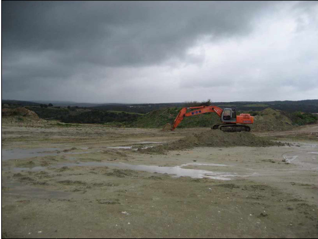
Abbildung 4-4: Abbau mittels Tieflöffelbagger
