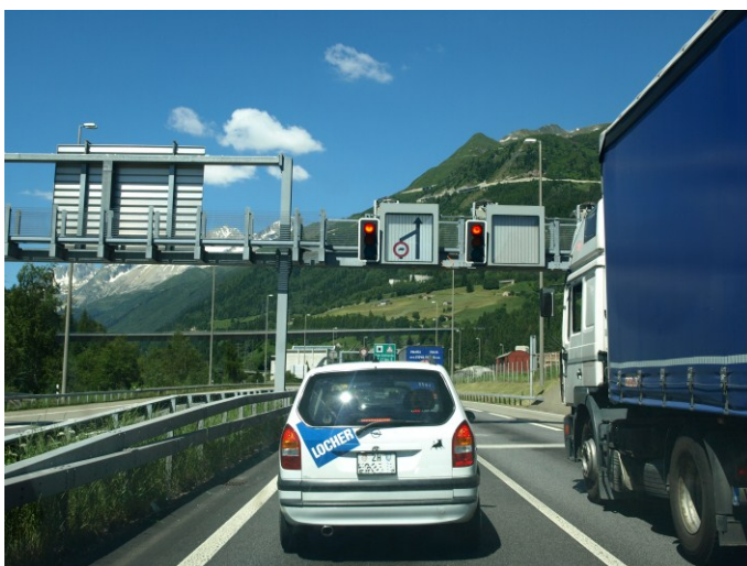
Abbildung V-7: Tropfenzählersystem [43]
