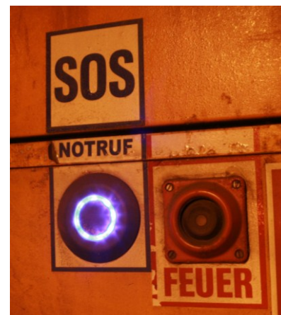
Abbildung III-16: SOS- und Feuertaster
