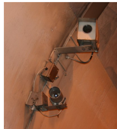
Abbildung III-17: Leuchtdichte- und Videokamera
