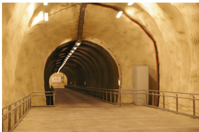
Abbildung V-4: Querschlag zwischen Bahn- und Straßentunnel [56]
