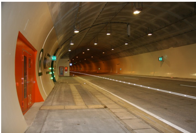
Abbildung III-4: Pannenschutzhütte mit FLN, NA und NRN [53]
