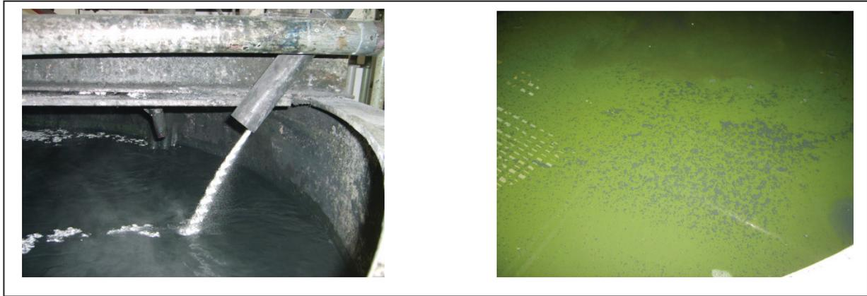
Abbildung 4: Optisches Erscheinungsbild des Abwassers im Abwassertank vor und nach der Chemikaliengzugabe
