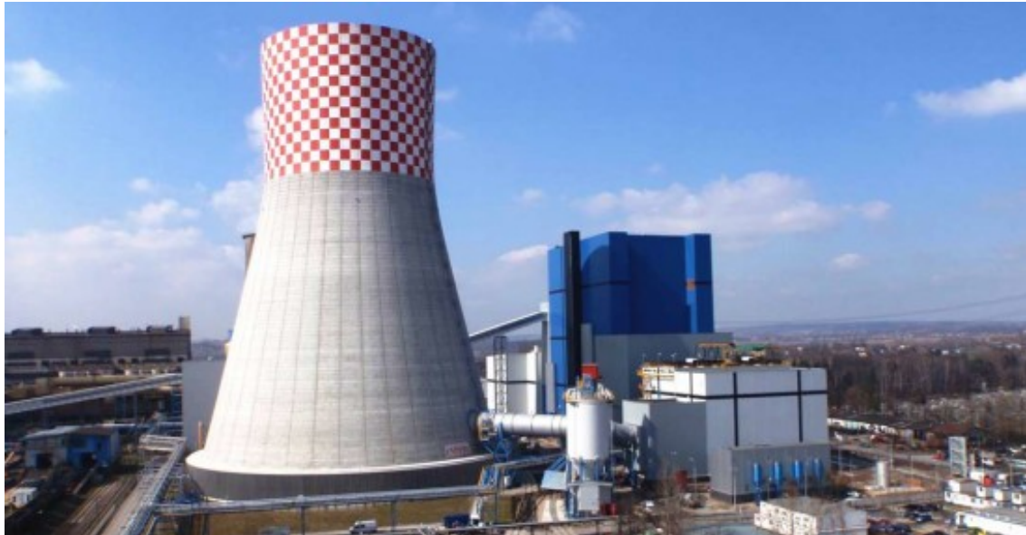
Abbildung 20: Lagisza CFB Kraftwerkskomplex [56]
