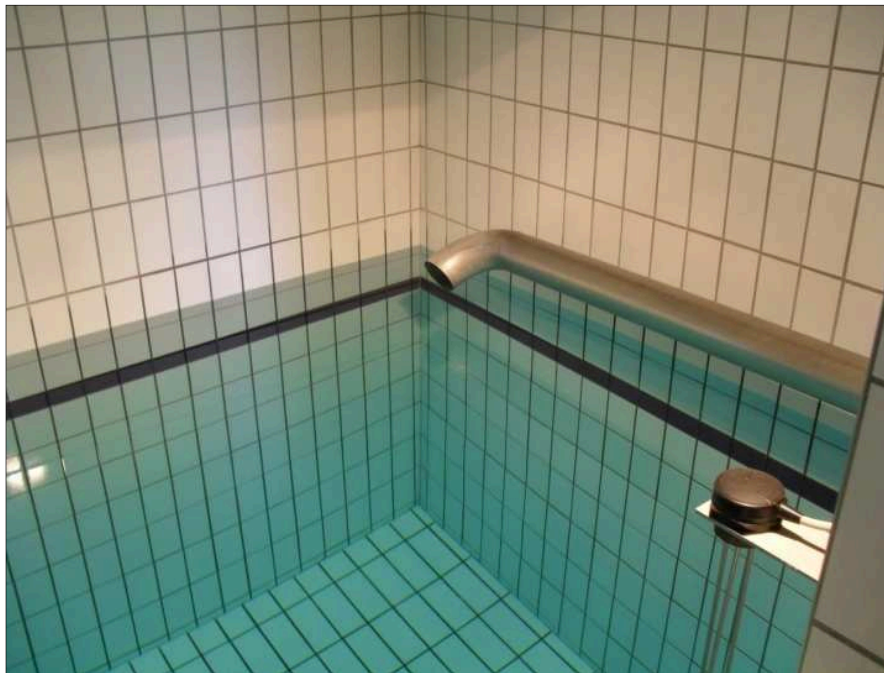
Abbildung 33: Geflieste Quellenstube im Quellhaus
