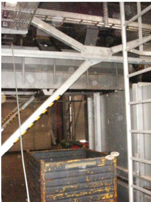
Abbildung 18: Probenahmestelle Auswurf 1 (PVC), Förderband H254
