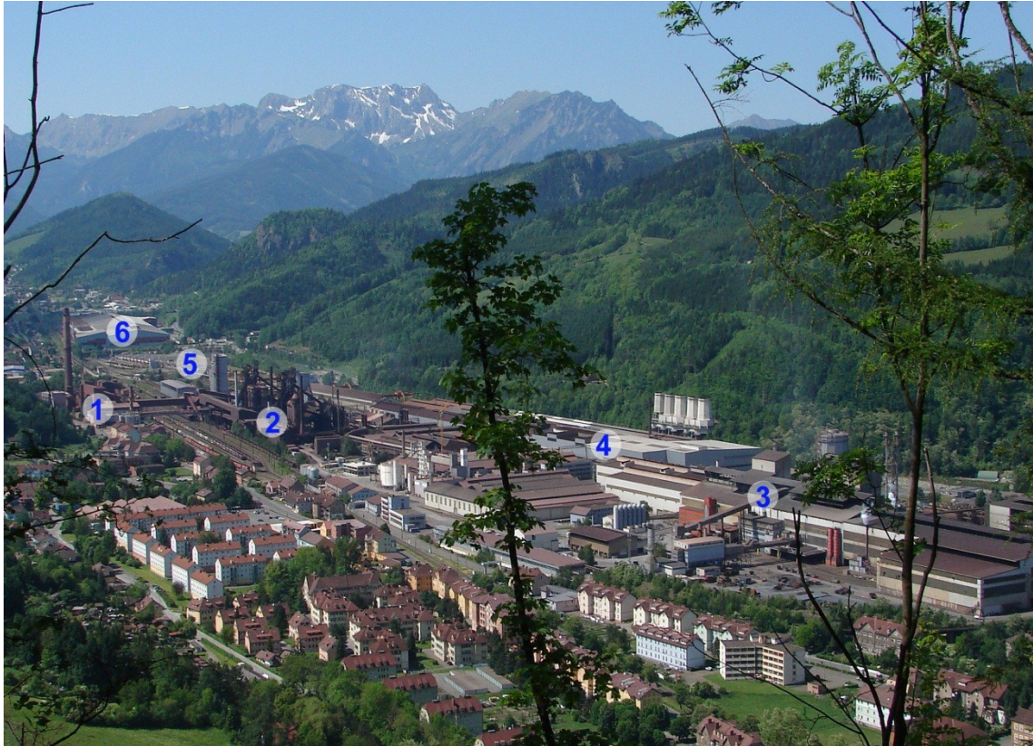
Abbildung 5 - Die Anlagen der voestalpine Donawitz: 1 Sinteranlage, 2 die beiden Hochöfen mit den numerischen Bezeichnungen eins und vier, 3 Stahlwerk, 4 Schienenwalzwerk, 5 Schienenlager, 6 Drahtwalzwerk
