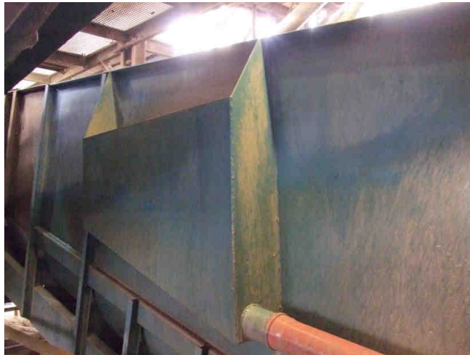
Abbildung 18: Probenahmestelle des Feinguts, Überlauf
