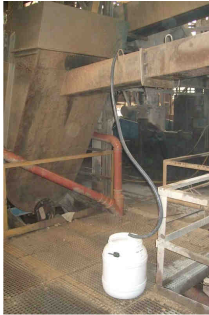
Abbildung 20: Probenahmestelle der Aufgabe, Zulauf
