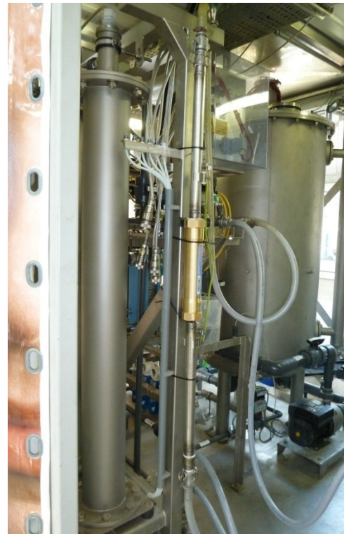
Abbildung 70: Einbauposition AQUABION®
