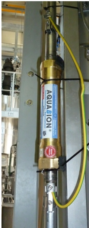
Abbildung 69: AQUABION® mit Überbrückung
