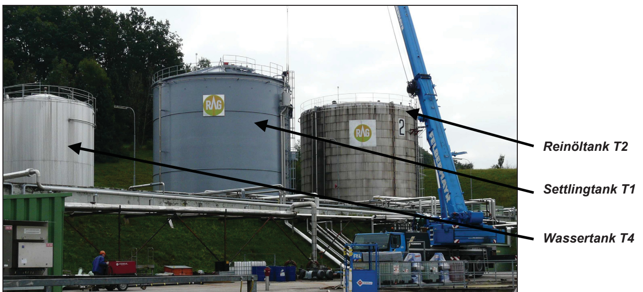
Abbildung 42 Die Zentralstation Voitsdorf nach den Instandhaltungsmaßnahmen [5]
