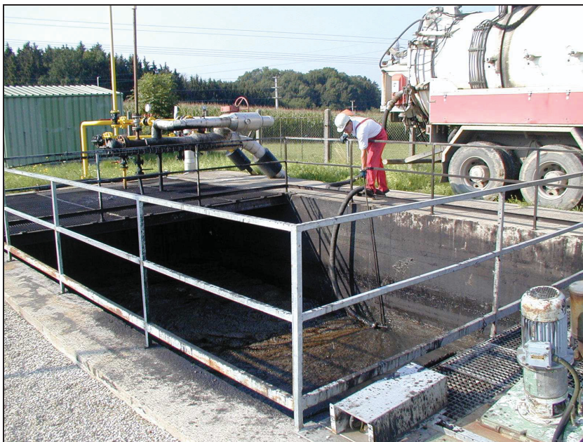
Abbildung 45 Reinigung der Klärbeckens [57]
