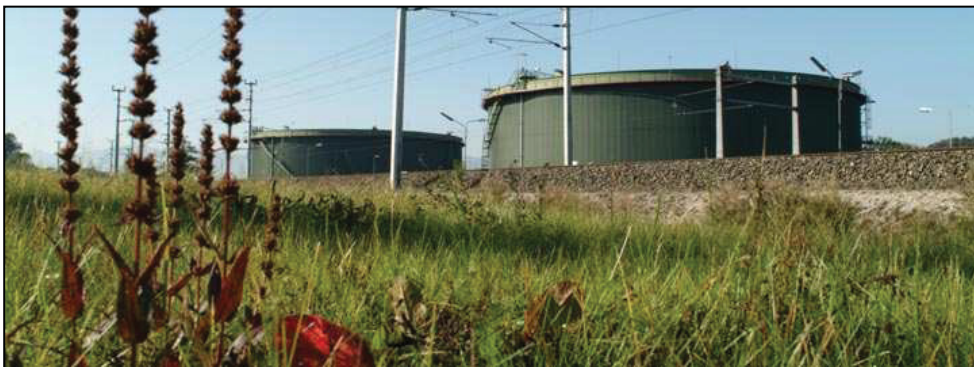
Abbildung 3 60.000 m 3 Lagertanks in Kremsmünster, Oberösterreich [1]
