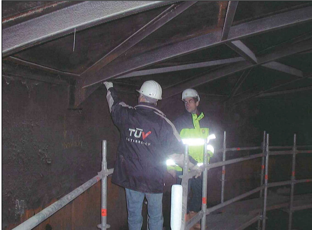
Abbildung 39 TÜV - Inspektion des Reinöltanks [5]
