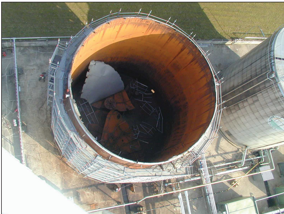
Abbildung 40 Demontage des Settlingtanks [5]
