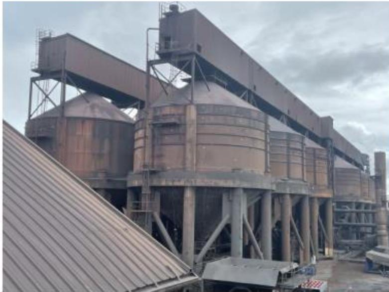
*Abbildung 20: Lagersilos für DRI [5]*
