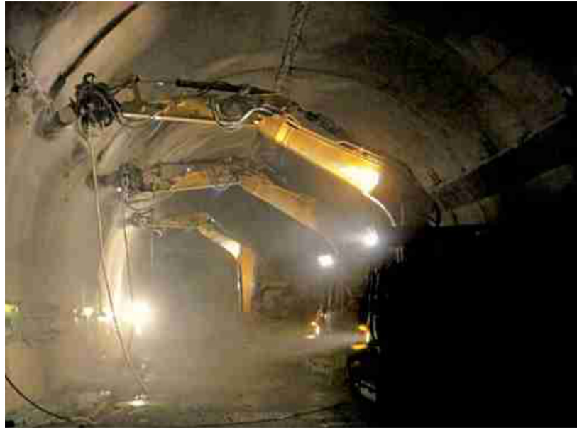
Abbildung 8: Anbaufräsen bei Profilierungsarbeiten [47].
