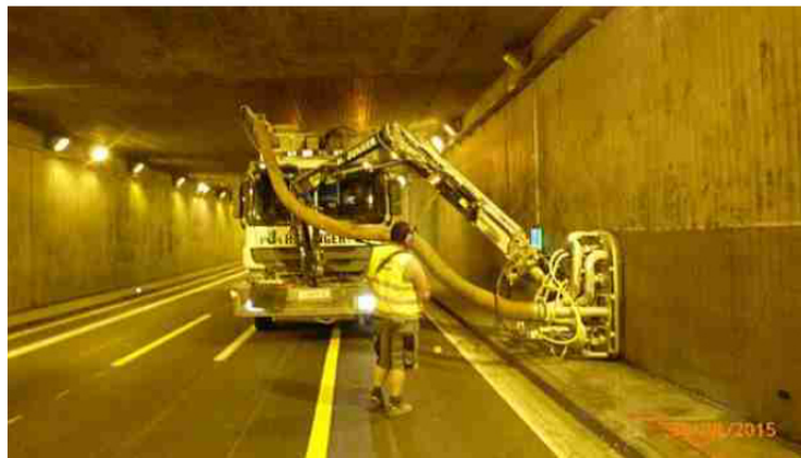
Abbildung 15: Maschineller Abtrag einer Tunnelbeschichtung in einem Straßentunnel [43].
