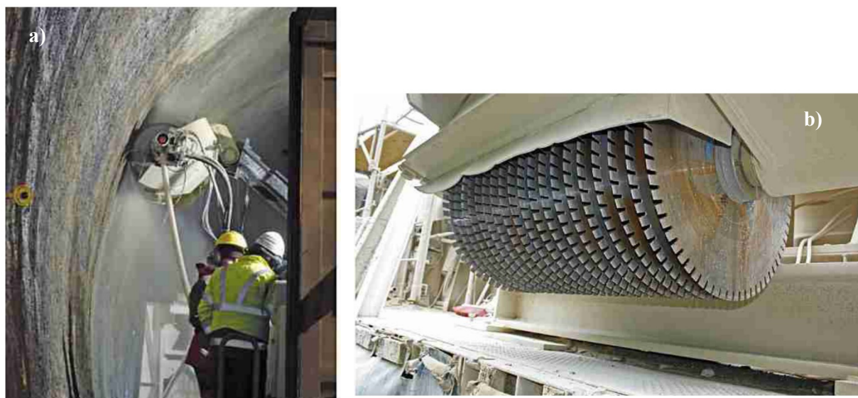
Abbildung 7: a) Profilsäge während des Arbeitsvorgangs. b) Detaildarstellung Profilsäge [41].
