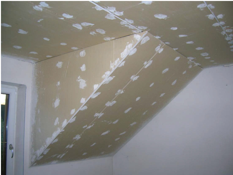
Abbildung 5: Verwendung von Gipskartonplatten im Dachgeschoßausbau
