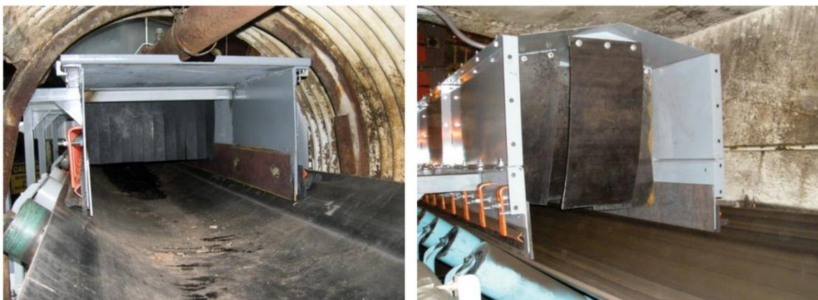
Abbildung 13: Zweistufige Staubvorhänge an Ein- und Austritt [5]
