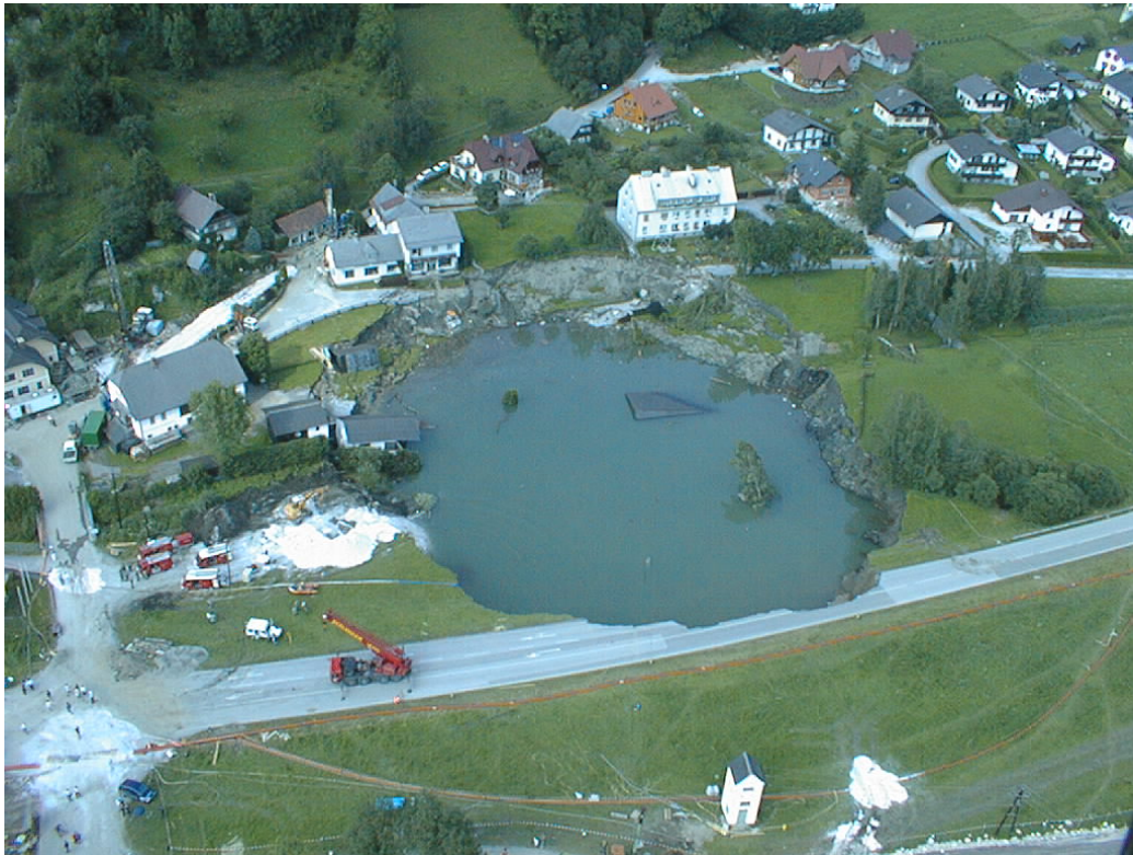
ABBILDUNG 8 – LUFTAUFNAHME GRUBENUNGLÜCK LASSING
