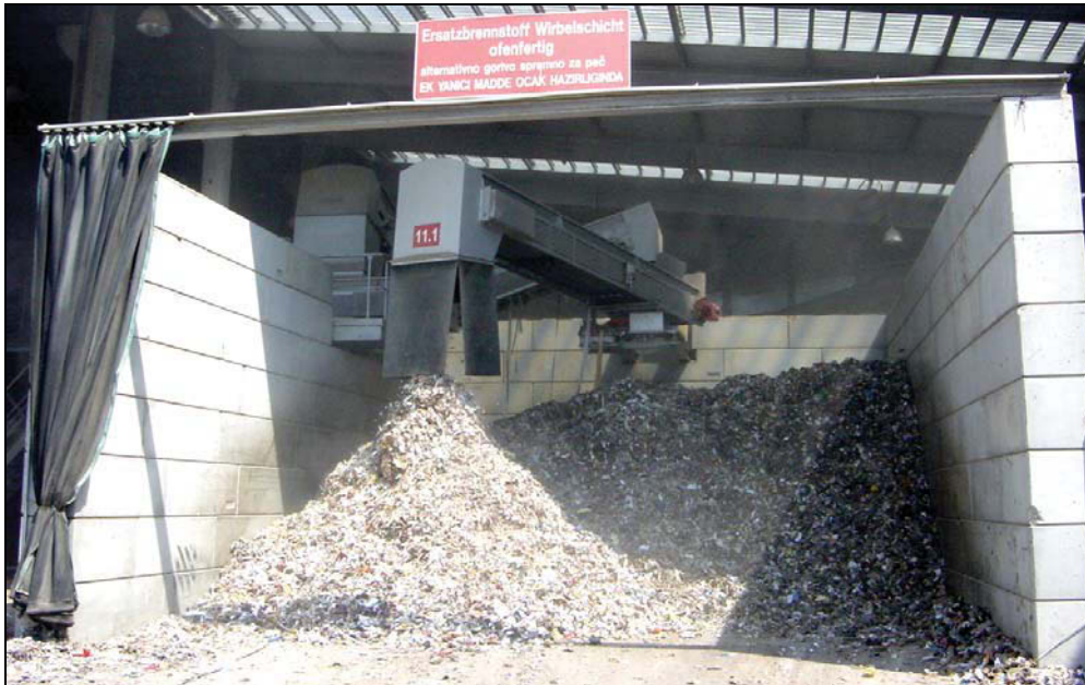
Anhang-Abb. 3: Bunker für EBS Wirbelschicht ofenfertig 20 – 80 mm
