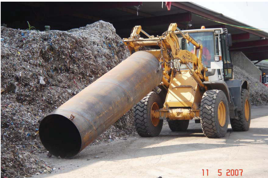
Abbildung 26: Entleerung des Hohlzylinders mit Hilfe eines Schaufelbaggers
