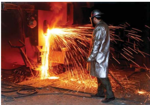
Abbildung 17: Freibrennen des Gießkanals mit Sauerstoffflanze
