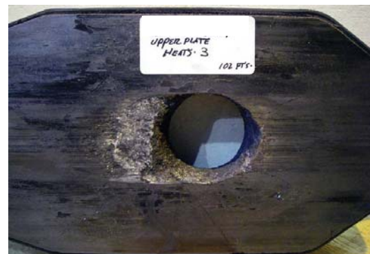
Abbildung 23: Korrosion der Oberplatte verursacht durch Calciumverbindungen im Stahl
