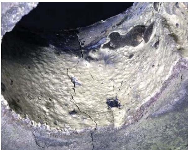
Abbildung 42: Bohrloch mit der anhaftenden Schicht
