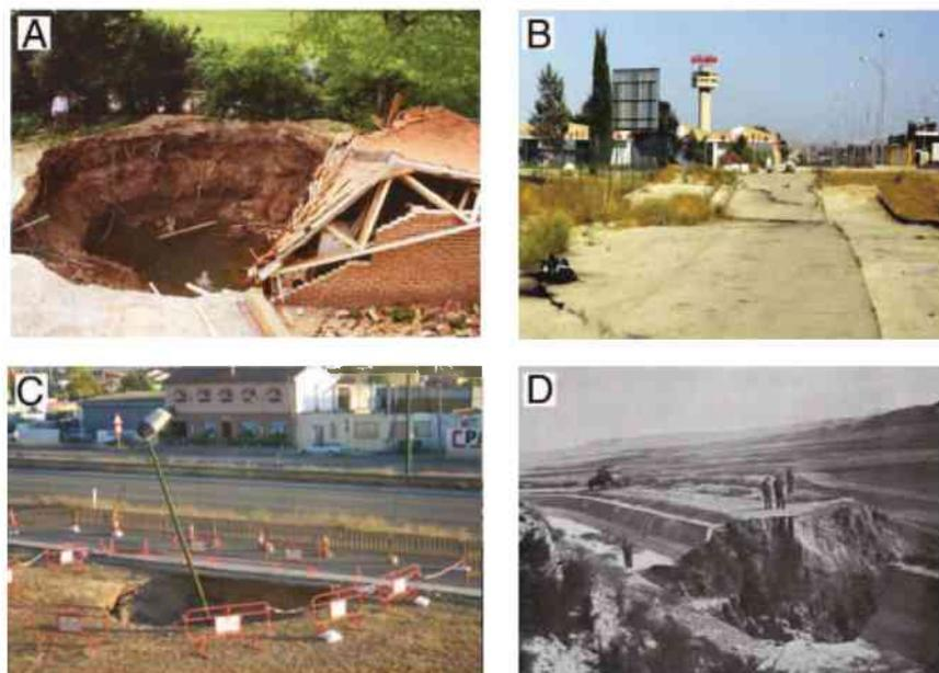
Abbildung II-14: (a) Erdfall in Ripon (England) 1997; (b) Beschädigung einer Schnellstraße (N-232) in Spanien durch weitreichende Absenkungen 1996; (c) Erdfall an der N-232 in Spanien 2006; (d) Beschädigung des La Violada Kanals in Spanien 1962; [90]
