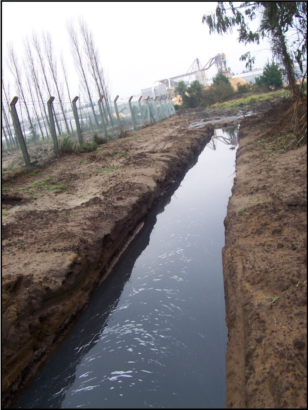
Figure XI.11. Aserradero Maderera Industrial El Colorado, Curanilahue.
