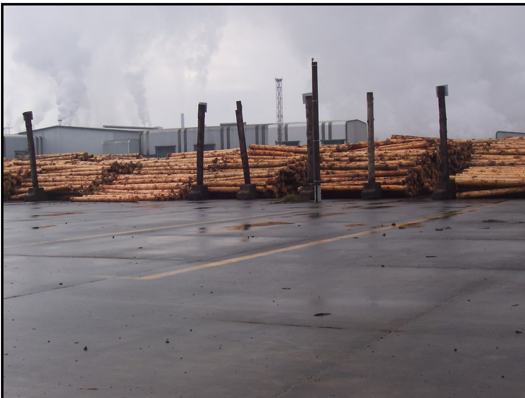
Figure XI.13. Aserradero Maderera Industrial El Colorado, Curanilahue.
