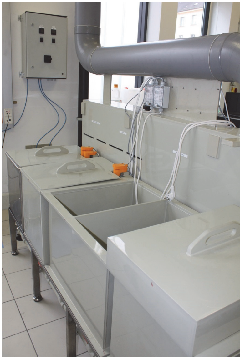
Abbildung 16-1: Teilansicht der Eloxieranlage während der Montage
