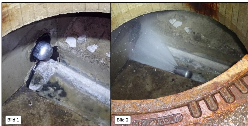
Abbildung 41. Bild 1: Spülung der Tragschichtdrainageleitung; Bild 2: Spülung der Transportleitung;
