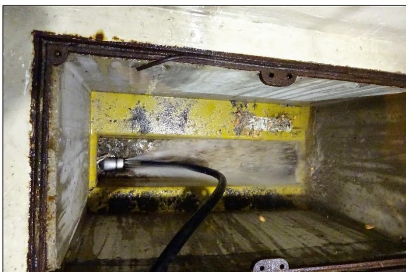
Abbildung 19. Bombendüse vor dem Einfahren in die Drainageleitung; UT Hausmannstätten
