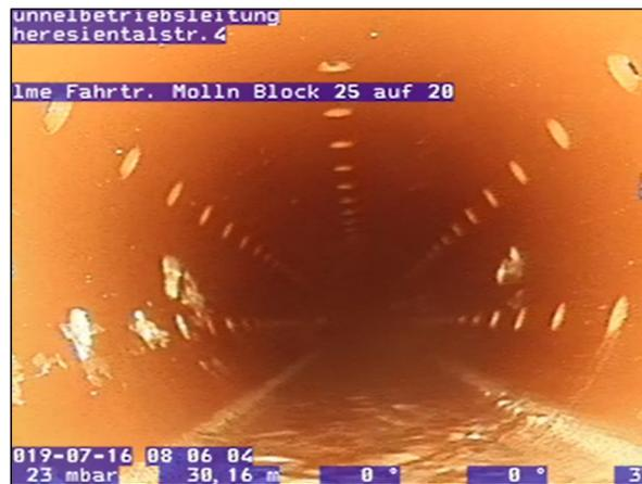
Abbildung 28. Standbild aus einer Kamerabefahrung der gereinigten Ulmendrainage; UT Grünburg;
