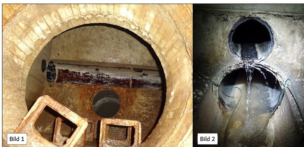
Abbildung 40. Bild 1: Brunnenschacht mit Überlaufbrunnen, Transportleitung und Tragschichtdrainage; Bild 2: oberhalb - Tragschichtdrainage DN 150, unterhalb - Transportleitung DN 300; Tunnel Reinertshof
