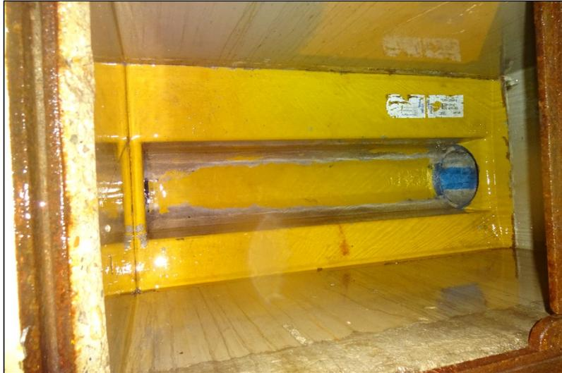
Abbildung 20. Gereinigte Haltung des Drainagesystems; UT Hausmannstätten
