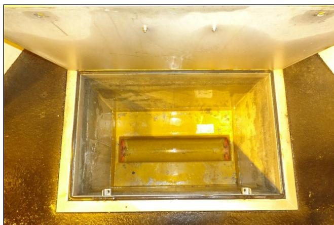
Abbildung 29. Ausführung der Fertigteilschächte der Bergwasserentwässerung; UT Grünburg
