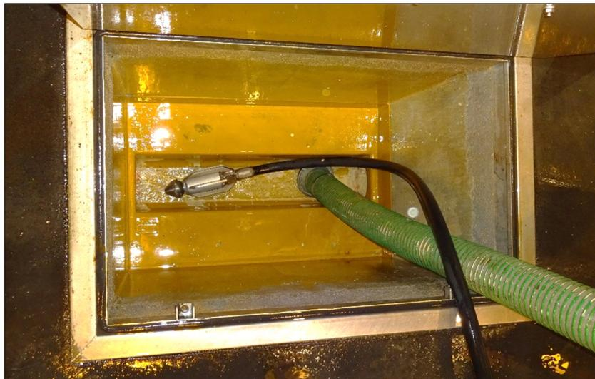
Abbildung 31. Düsenkopf am Wasserschlauch und Absaugschlauch im Schacht der Ulmendrainage; UT Grünburg
