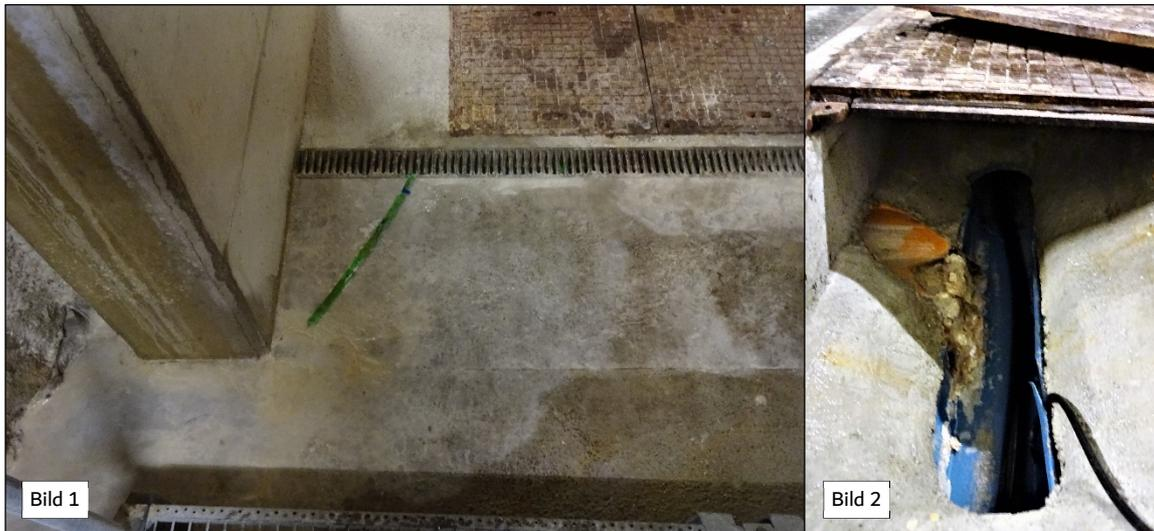
Abbildung 15. Bild 1: Entwässerungsrinne vor dem Entlüftungsschacht; Bild 2: Querausleitung der Entwässerungsrinne in die Ulmendrainage des Querschlag; UT Hausmannstätten
