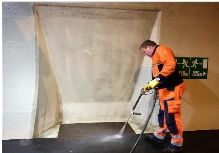
Abbildung 16. Putznische mit abgedecktem Fertigteilschacht; UT Hausmannstätten
