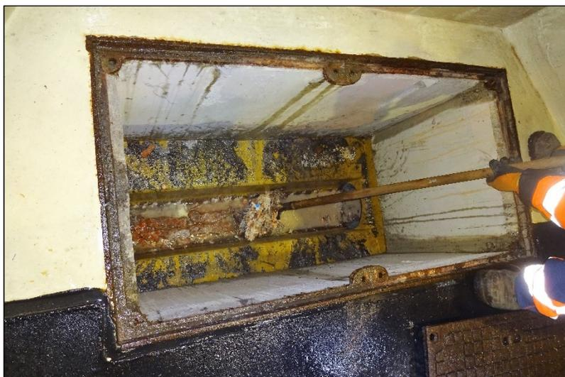
Abbildung 18. Entfernung der abgebauten Härtestabilisatoren; UT Hausmannstätten
