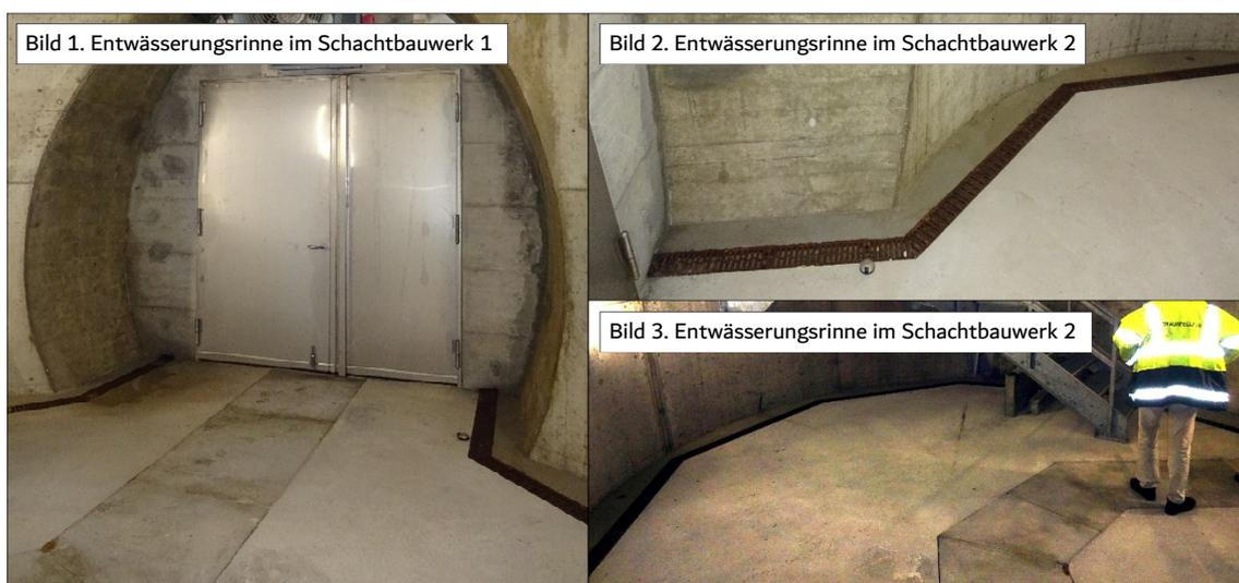
Abbildung 30. Lage der Entwässerungsrinnen im Schachtbauwerk 1 und 2; UT Grünburg
