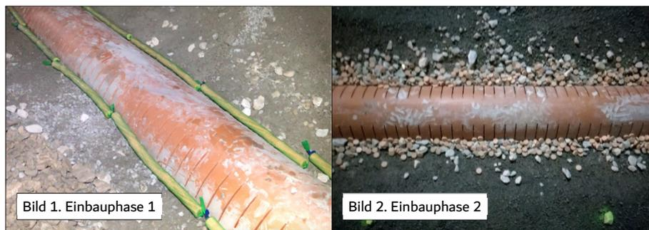
Abbildung 51. Ausgebrachte Härtestabilisatoren Baypure® DSP Tabs 200 – Polysuccinimid-Deposteine, Bild 1: 50-cm-lange Schlauchnetze á 294 g, Bild 2: lose ausgestreute Deposteine – 2 x 500 g pro Laufmeter; Forschungseinrichtung "Zentrum am Berg"
