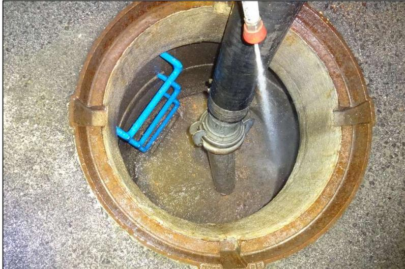
Abbildung 22. Absaugung der Verunreinigungen aus dem Schlammfang; UT Hausmannstätten
