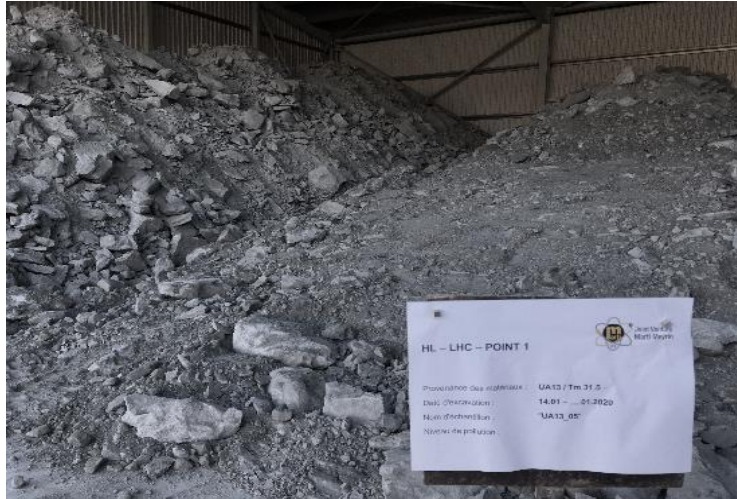
Figure 4. Identification des stocks temporaires de matériaux potentiellement pollués aux hydrocarbures
