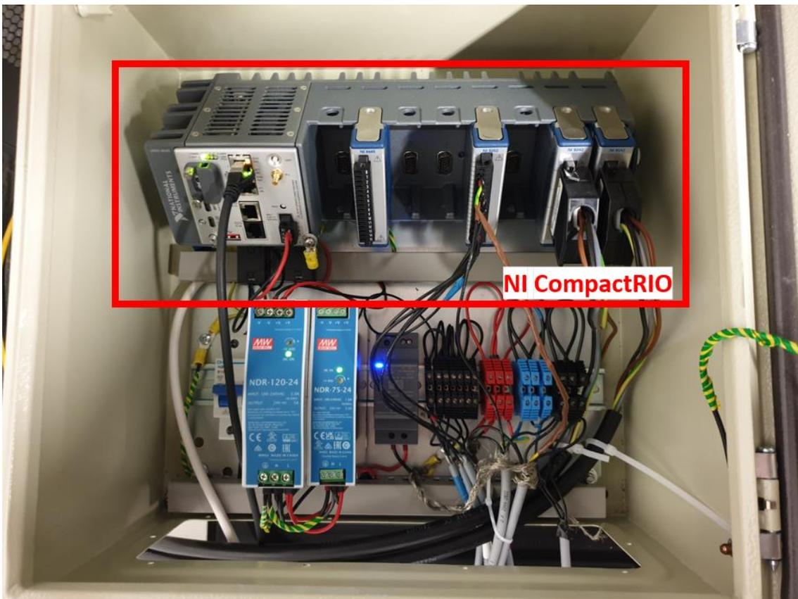
Abbildung 32: Schaltkasten des cRIO
